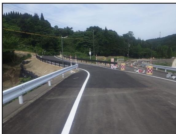
6/11 仮設道路による交通開放 国道359号 小矢部市内山
