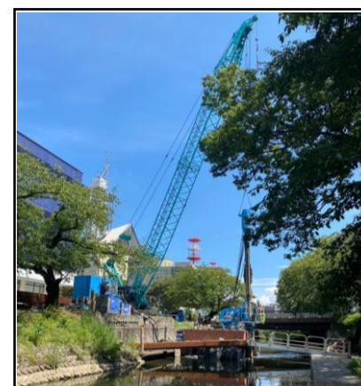
災害復旧工事 一級河川松川 富山市新総曲輪
