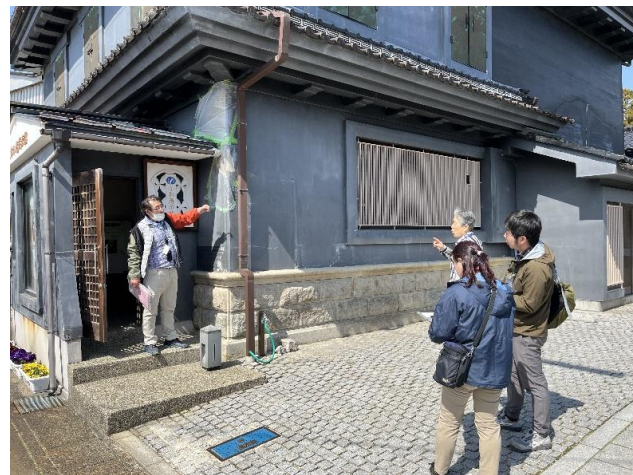
1次調査の様子（射水市）
