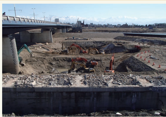
平成26年1月 たくさんの機械で橋の土台を取りはらう
