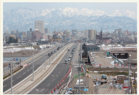
平成25年2月 旧富山大橋の中央部を取りはらう
