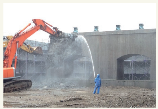
平成25年12月 橋の土台(コンクリート)を取りはらう
