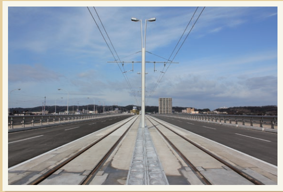
景色がよく見えるように、路面電車の電柱と照明灯の柱を一つにまとめたセンターポールとしました。
