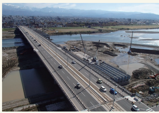
平成25年11月 神通川をしめ切り、旧橋の左岸側を取りはらう
