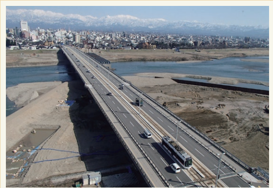
平成26年3月 旧橋の左岸側をすべて取りはらう
