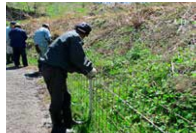
侵入防止柵の設置
