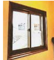
住宅 窓の断熱化
