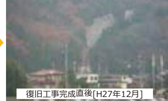
復旧工事完成直後[H27年12月]
