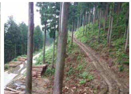
林業機械が走行する森林作業道
