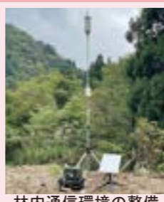
林内通信環境の整備
