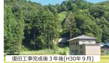
復旧工事完成後3年後[H30年9月]
