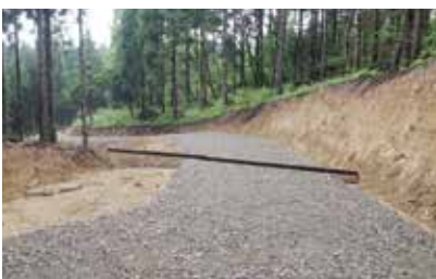
スギ林内に完成した林業専用道
