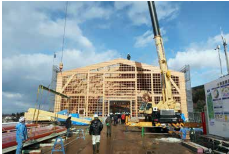
C L Tを活用し建設中の木造建築物を題材とした現地研修会
