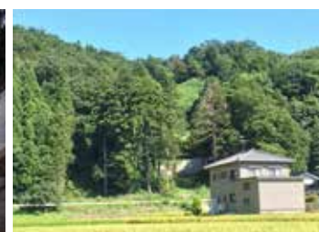
工事完成3年後 (平成30年9月撮影)
