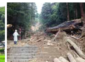
被災直後 (平成26年7月撮影)
