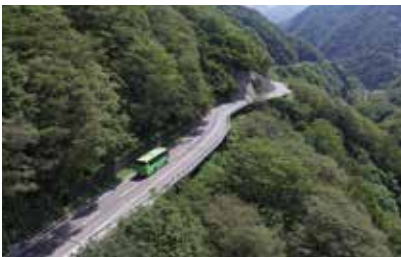
2車線化が完成した山のみち林道有峰線
