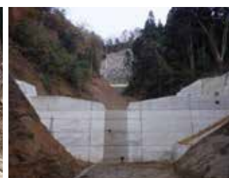
工事完成直後 (平成27年12月撮影)
