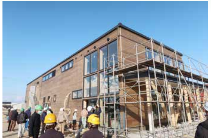
建設中の木造建築物を題材とした現地研修会
