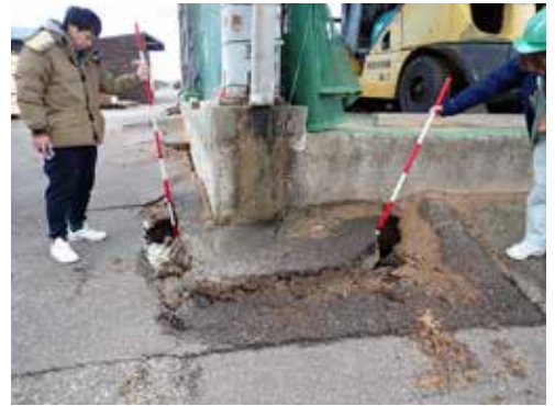
木材加工施設の液状化被害（氷見市万尾）
