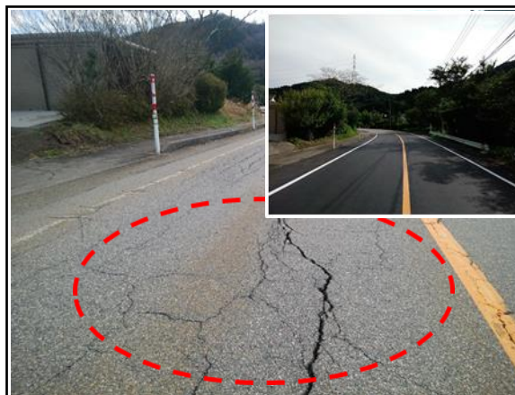
施設の復旧状況
