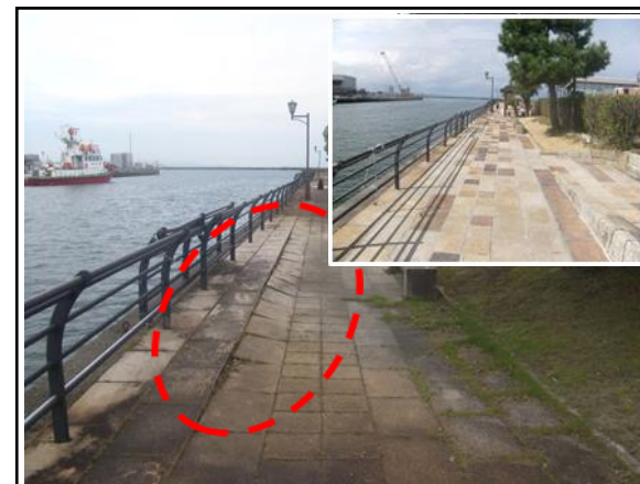
施設の復旧状況
