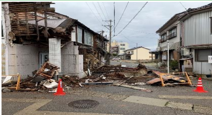
倒壊した家屋（氷見市）
