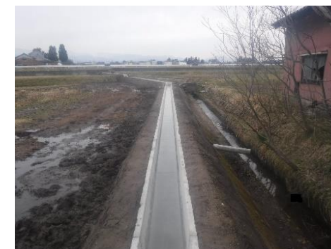
農業用水路の改修
