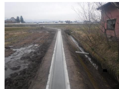
農業用水路の改修
