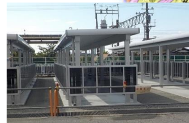
駐輪場の改修整備
