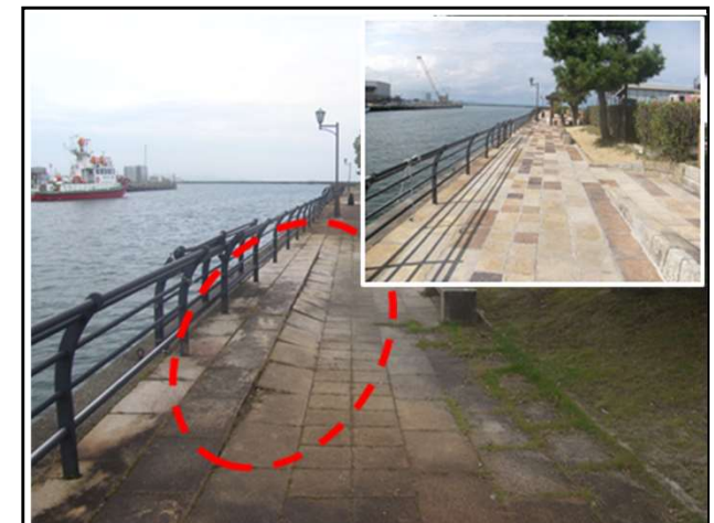
施設の復旧状況 岩瀬運河緑地 富山市岩瀬諏訪町
