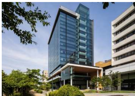
【新築】防災危機管理センター
