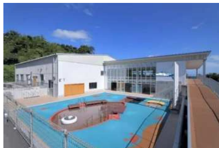
改修後の県栽培漁業センター
