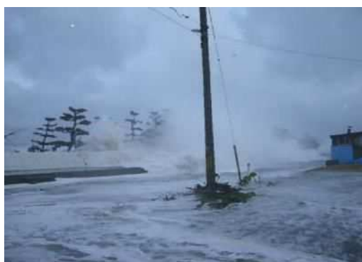
高波による越波状況(入善漁港)
