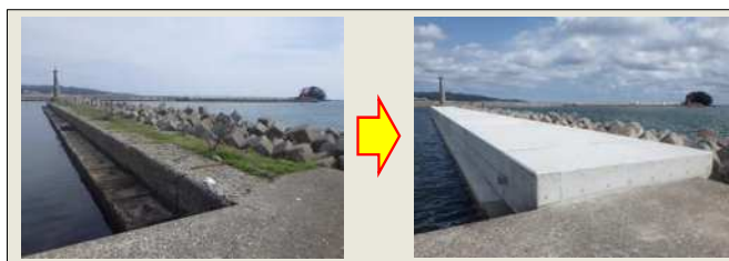
漁港施設の長寿命化対策
