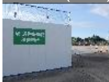
積替保管場(金沢市)
