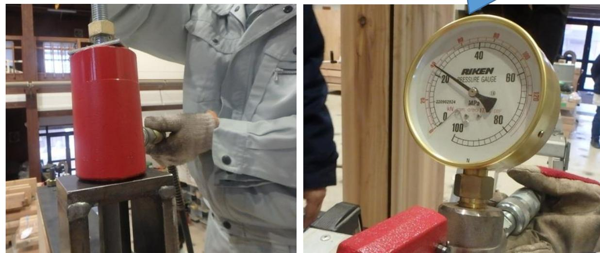
鋼棒を油圧ジャッキで引っ張り、ナット固定
