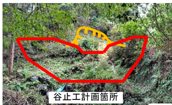
八尾町三田 (R5.7豪雨による山腹崩壊)
