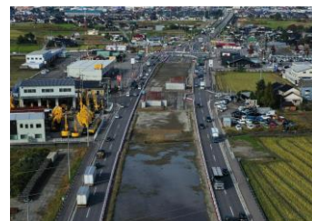
国道8号豊田新屋立体
