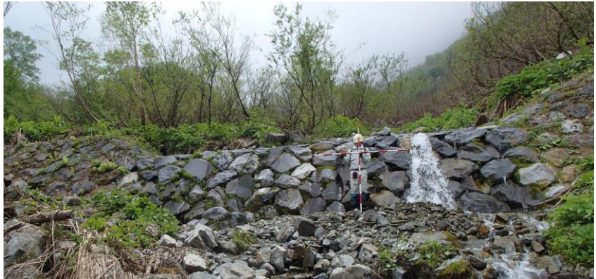
西ノ谷に 現存する堰堤
