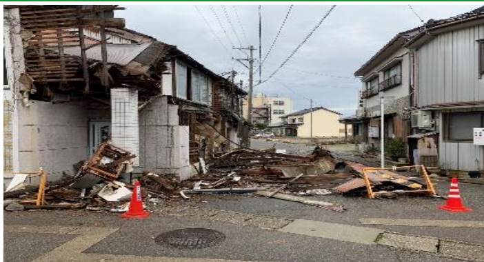
倒壊した家屋（氷見市）
