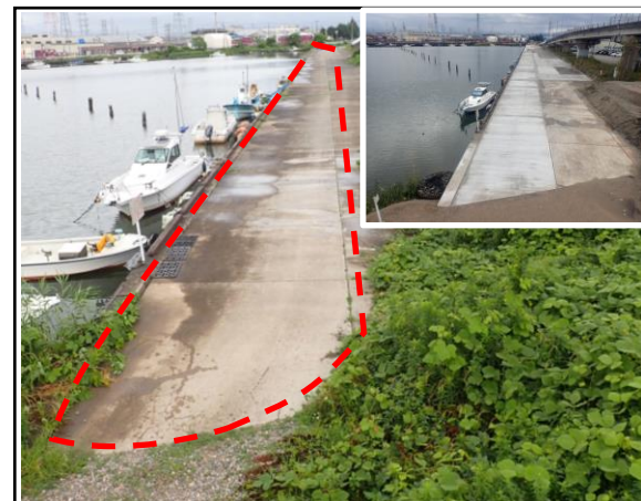
施設の復旧状況 吉久物揚場 高岡市荻布
