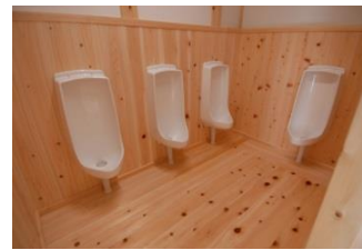
改修された山小屋のトイレ
