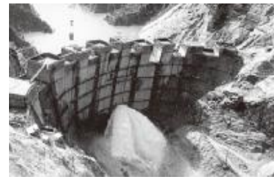
黒部ダム建設時の様子
