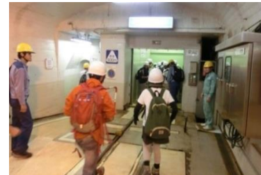
豎坑エレベーター
