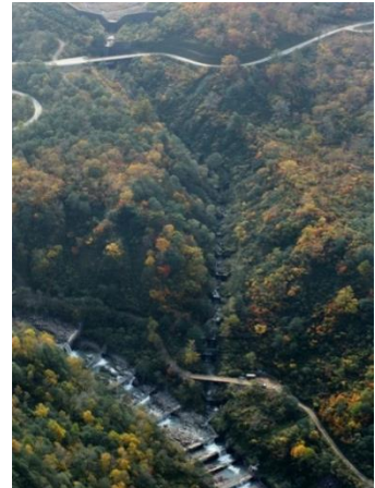
泥谷砂防堰堤群(国登録有形文化財)
