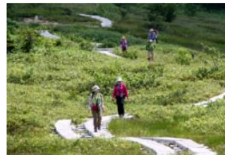
弥陀ヶ原の木道再整備
