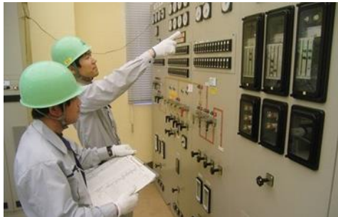
発電所点検作業
