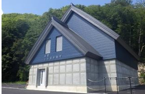
上百瀬発電所（小水力発電所）
