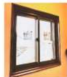
住宅 窓の断熱化
