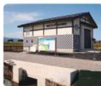
仁石エ門用水発電所
