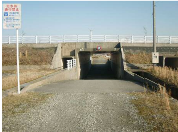
海側から山側を望む
