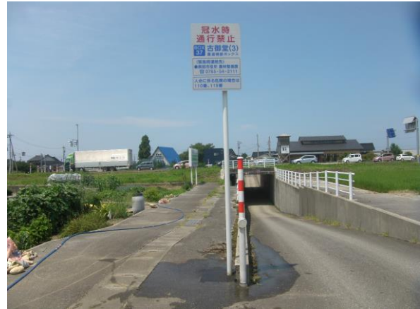
山側から海側を望む
