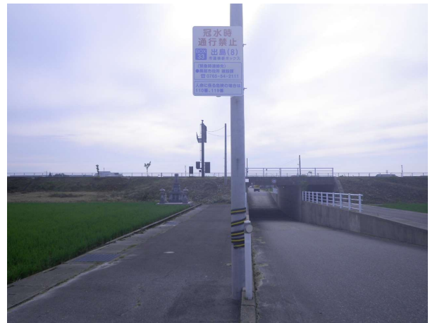
山側から海側を望む
