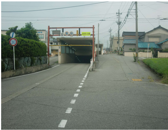
海側から山側を望む
