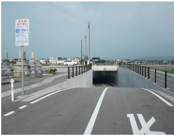
海側から山側を望む
