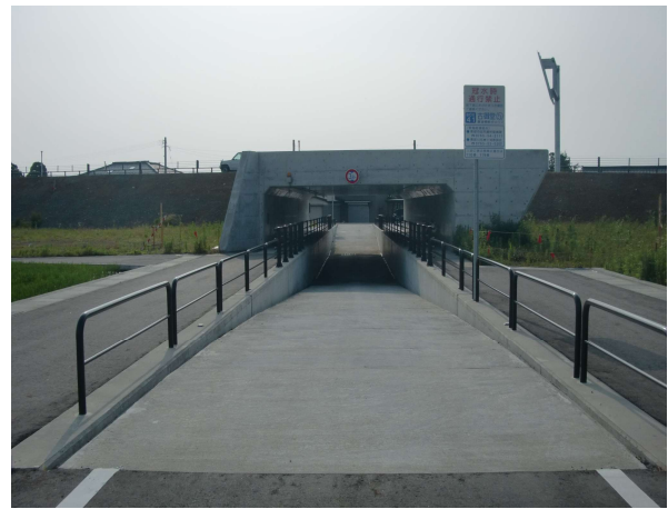
山側から海側を望む
