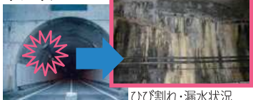
ひび割れ・漏水状況
