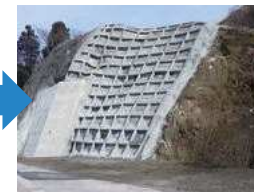
法枠吹付工の整備
