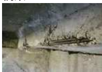
鉄筋露出の発生状況
