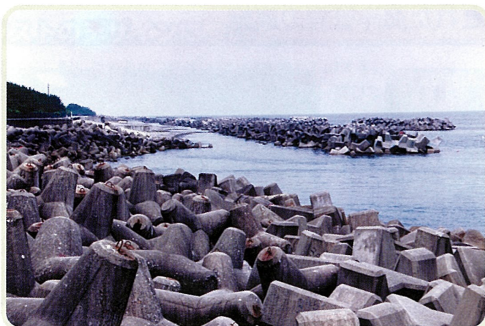
● 海岸を幾重にも覆いつくした消波ブロック 大屋海岸（朝日町）
