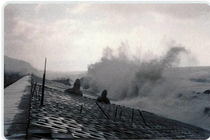
● 飛散した消波ブロック 境海岸（朝日町）
