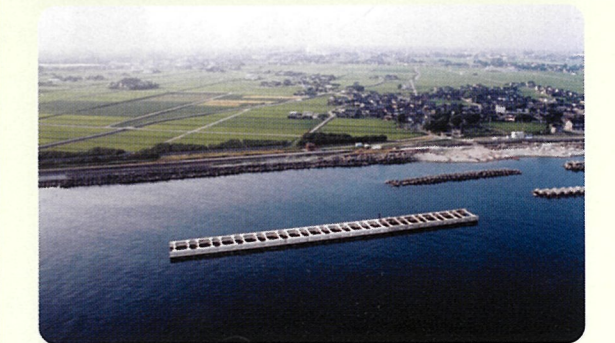
新型離岸堤(下新川海岸)
