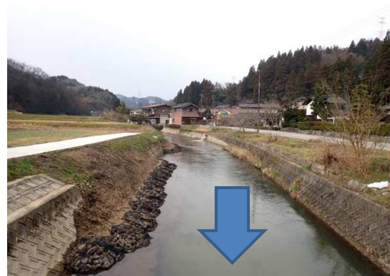
河道浚渫実施後(上庄川)
