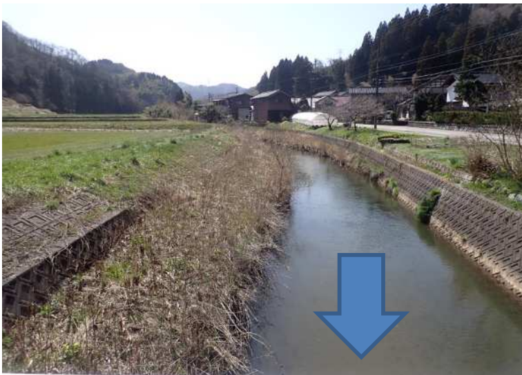
河道浚渫実施前(上庄川)
