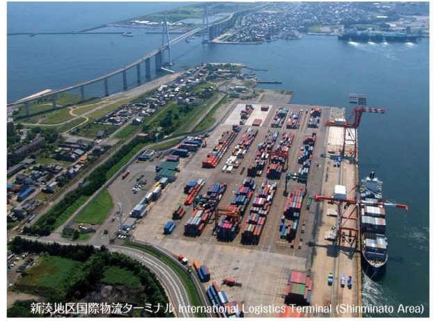
新湊地区国際物流ターミナル International Logistics Terminal (Shinminato Area)
