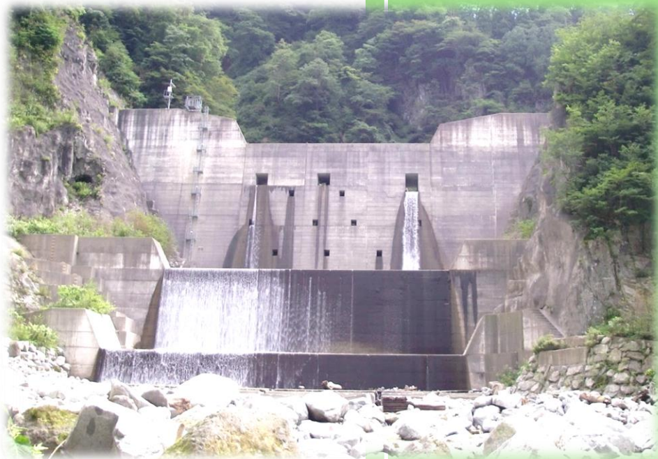
砂防設備 堰堤工（立山町雑穀谷）
