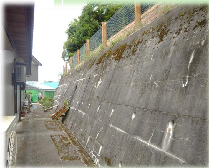
急傾斜地崩壊防止施設 擁壁工（魚津市観音堂地区）
