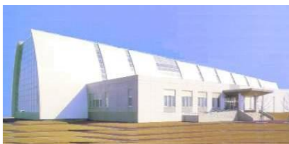
処理水をプールの昇温に利用(海竜スポーツランド)
