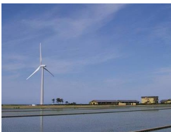
入善浄化センター(入善町)の 風力発電施設
