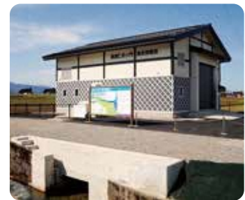
仁右エ門用水発電所
