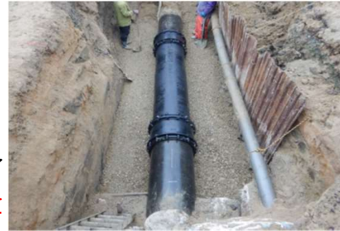
農業用水パイプラインの復旧
