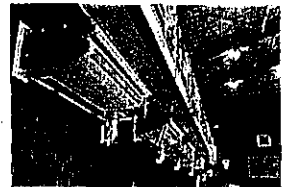
体育館の空調設備
