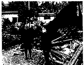
姿地区の家屋倒壊現場を目に焼き付ける令和6年1月11日
