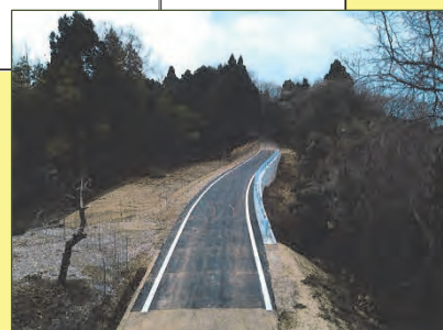
林道法華三尾線(氷見市) 復旧完了
