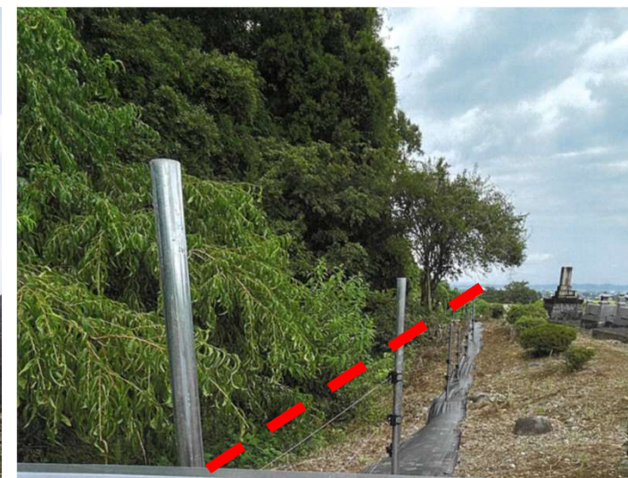
電気柵設置（富山市松野 地区）
