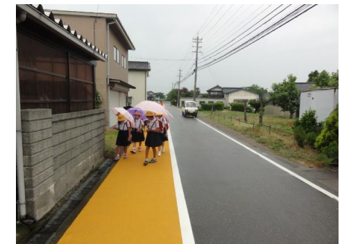
道路の交通安全対策（路肩拡幅後）
