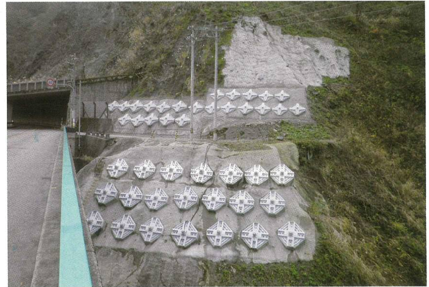
(株岡部施工の「一般国道 156 号道路総合交付金（防災・災防・ 修繕）法面工工事」
