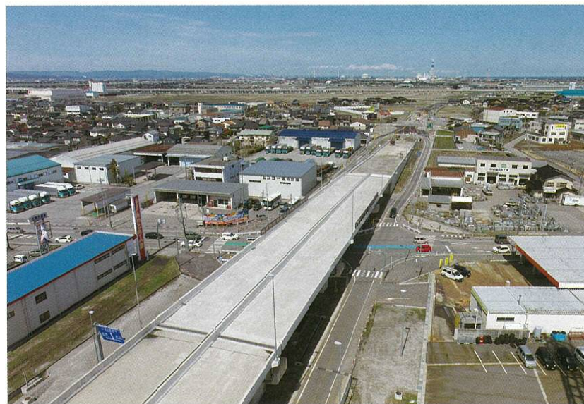
佐藤鉄工(株)施工の「主要地方道小杉婦中線道路総合交付金 戸破高架橋上部工その2工事」
