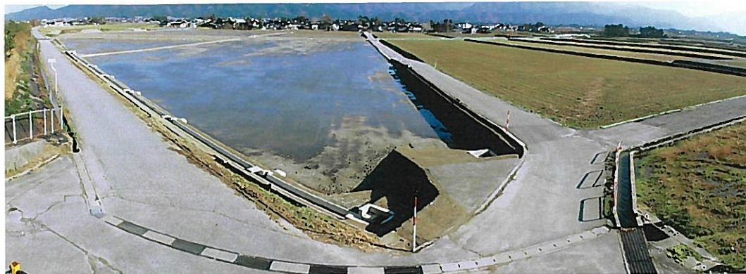
竹田建設(株)施工の「ほ場整備窪田地区第5工区ほ場整備工事」
