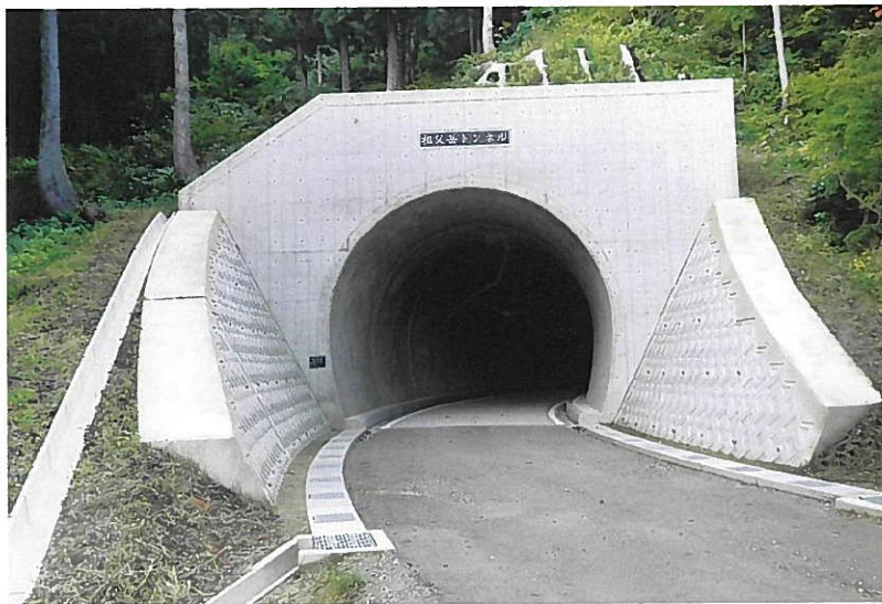
佐藤工業・北尾工業共同企業体施工の「県営林道道整備交付金祖父岳線桂原・谷折トンネル工事」
