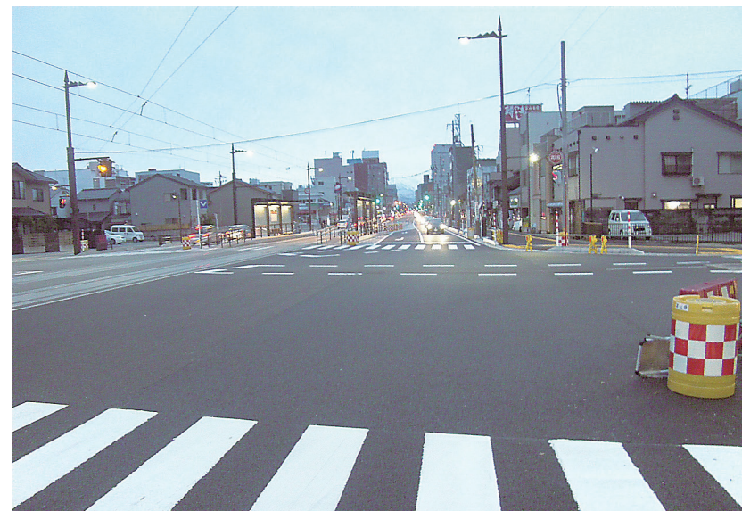
朝日建設(株)施工の「都市計画道路呉羽町袋線街路総合交付金（富山大橋）舗装その2工事」
