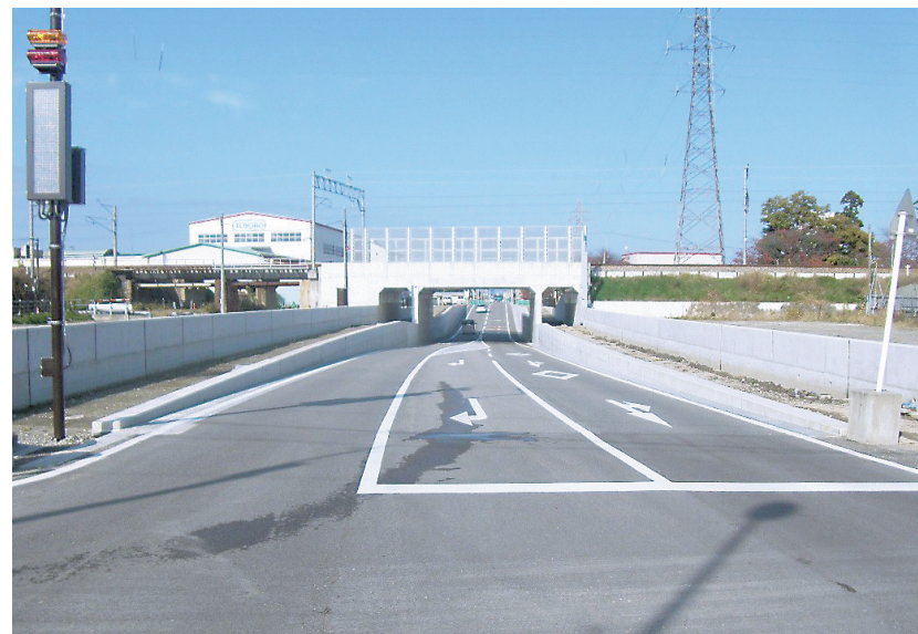
川原工業(株)施工の「都市計画道路二口北野線街路総合交付金道路改良擁壁工第2工区工事」
