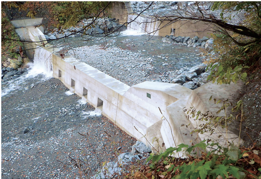
(株)音沢土建施工の「復旧治山「大尾」溪間工事」
