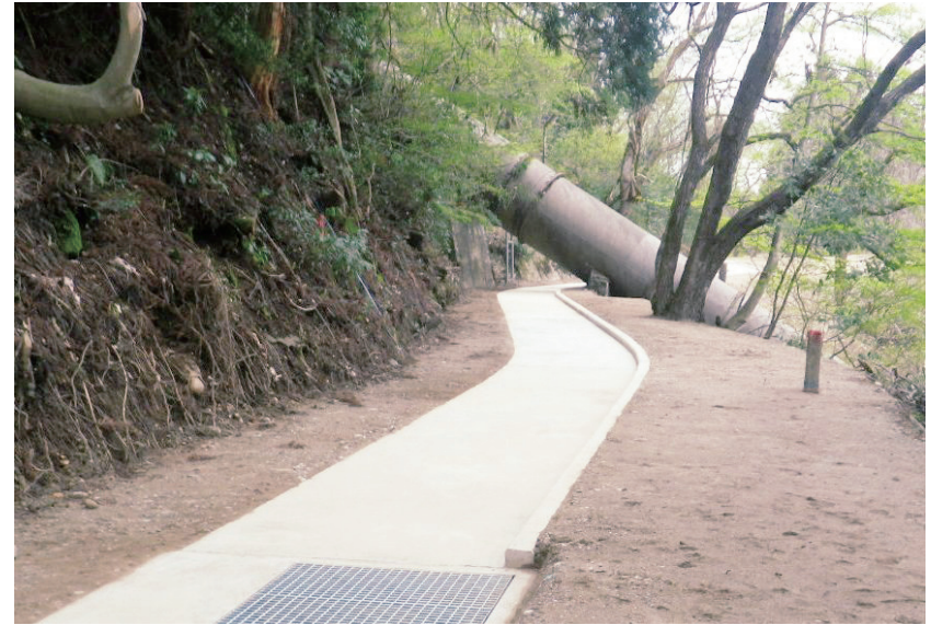
伊藤建設(株)施工の「ため池等整備島尻地区宮谷水路第2工区工事」
