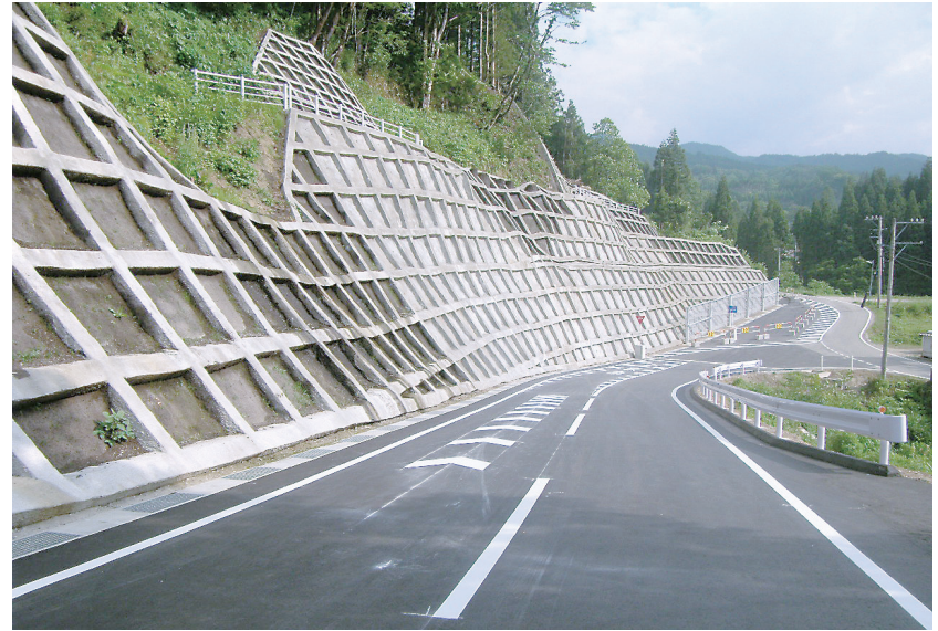
岡本工業(株)施工の「山のみち交付金林道大沢野・八尾線上笹原工区開設工事」
