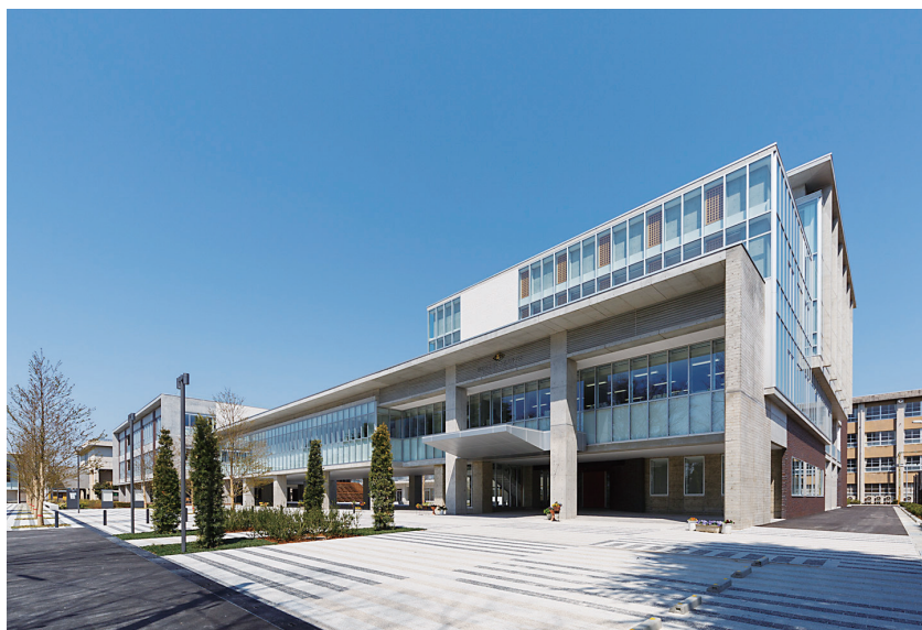
辻建設・林建設共同企業体施工の「富山県立富山中部高等学校東校舎新築工事」
