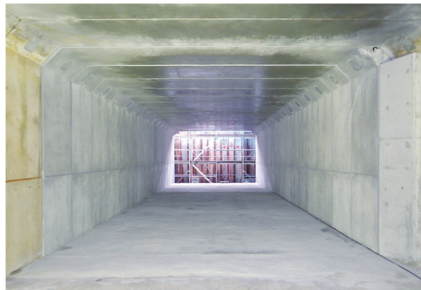
八倉巻建設八倉巻仁志施工の「中川水系沖田川河川総合交付金放水路工事」
