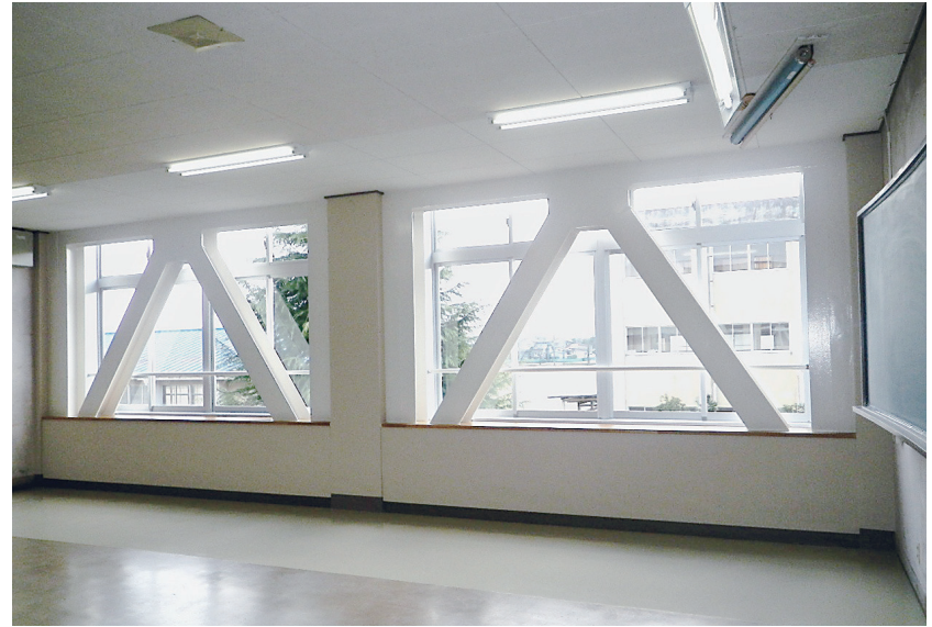
タカノ建設(株)施工の「富山県立富山西高等学校管理教室棟耐震補強工事」
