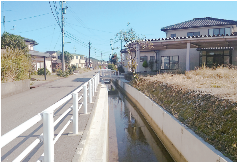
水新建設(株)施工の「ため池等整備下大久保地区下大久保水路第4工区工事」
