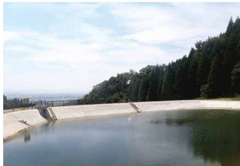
(株)森長組施工の「ため池等整備室田地区大平ため池改修工事」
