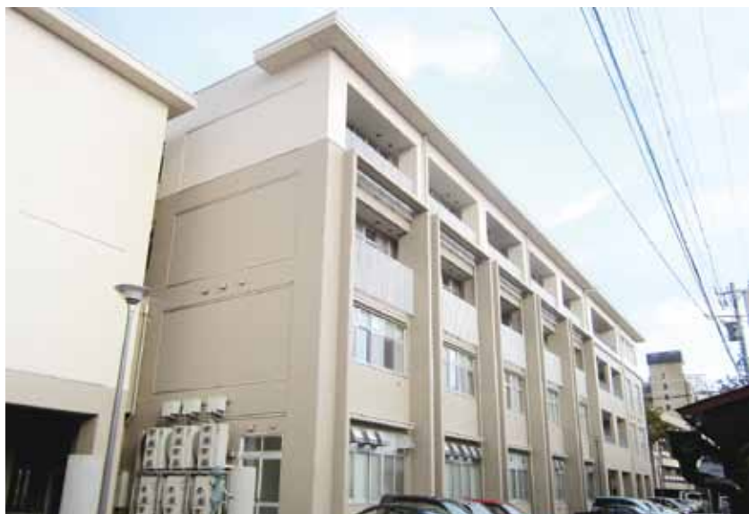
塩谷建設・林建設共同企業体施工の「富山県立雄峰高等学校南校舎新築工事」
