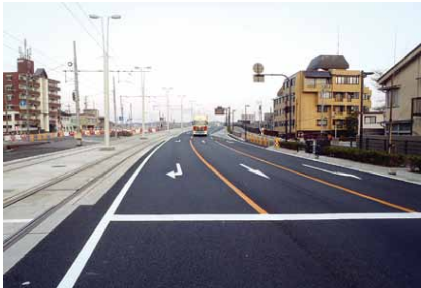
(榎林土木施工の「都市計画道路呉羽町袋線街路総合交付金（富山大橋）舗装工その2工事」
