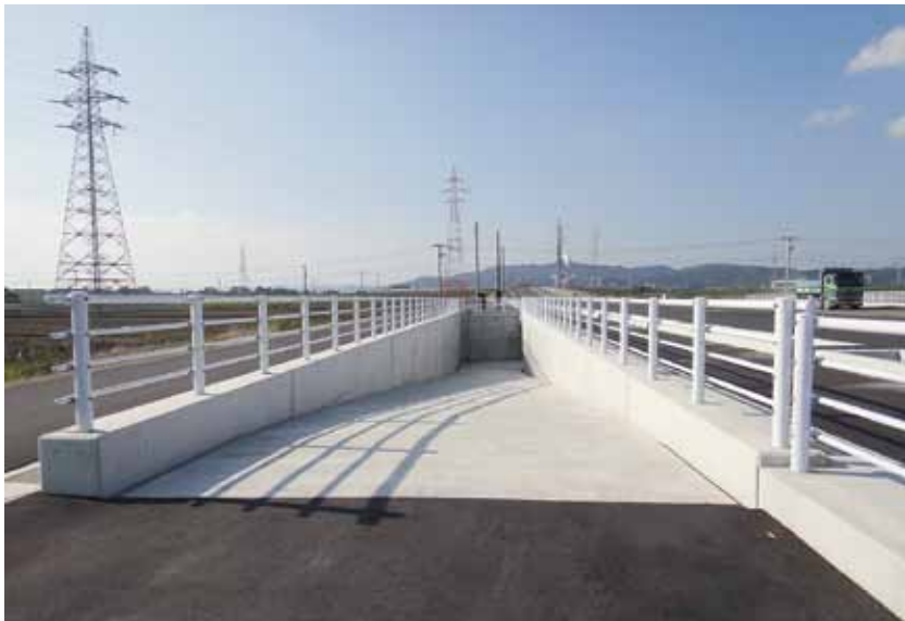
(株)早木工業施工の「一般県道姫野能町線道路総合交付金地下横断道路第1工区工事」
