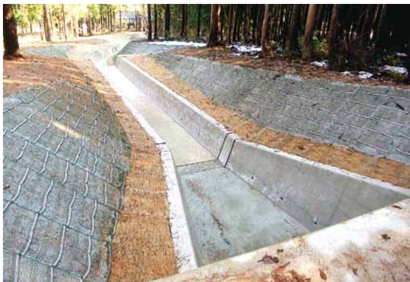
野原建設(株)施工の「復旧治山上百瀬溪間工事」
