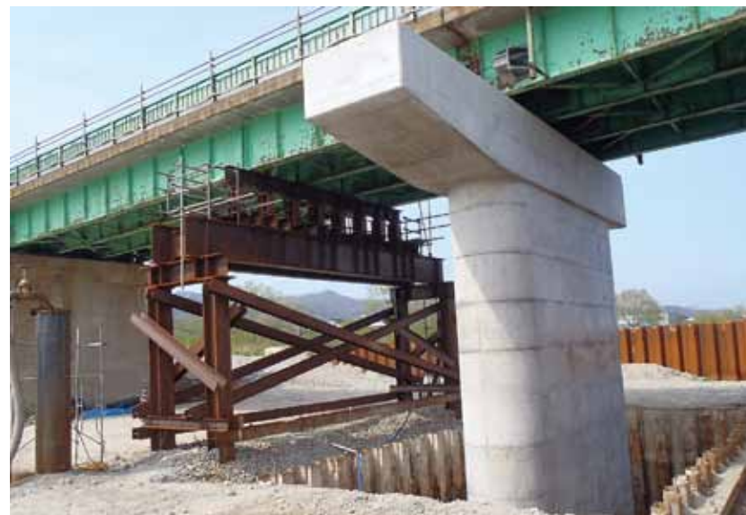
昭和建設(株)施工の「一般県道守山向野線道路総合交付金（二上橋）橋脚工工事」
