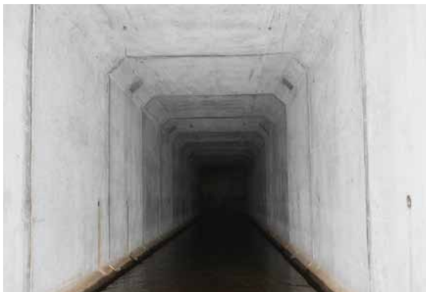
(株)フタカワ施工の「農地防災庄川左岸一期地区新又口排水路第9工区工事」
