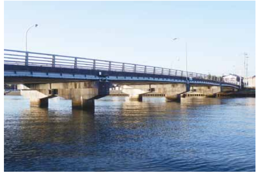
川田建設(株)北陸支店施工の「主要地方道富山魚津線道路総合交付金（浦の橋）耐震補強工事」
