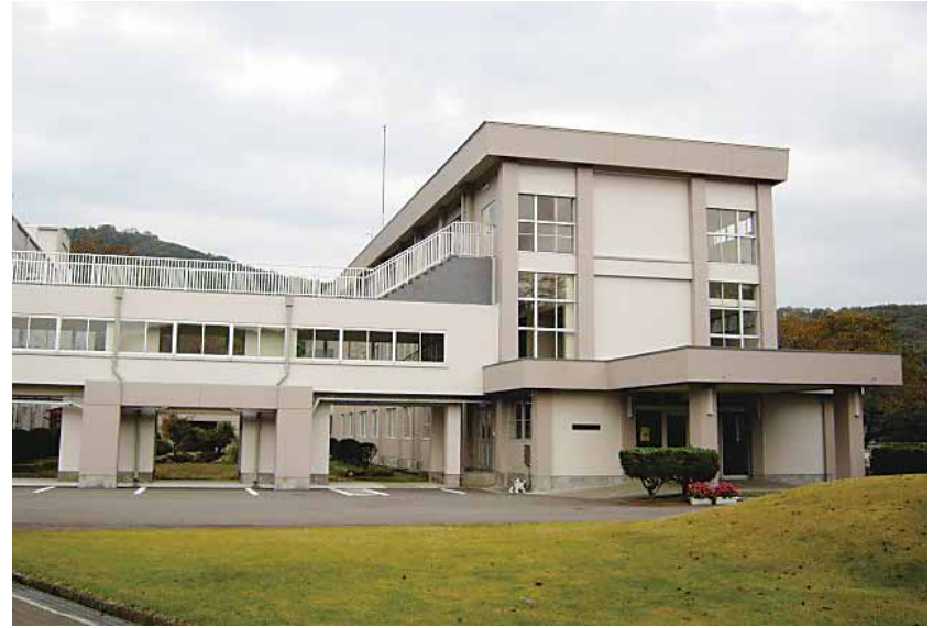
寺崎工業(株)施工の「富山県立西部高等特別支援学校（仮称）管理 教室棟外改修工事」
