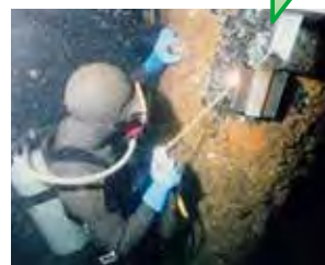
港湾岸壁の防食機能維持
