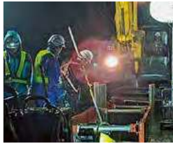
生活インフラを支える夜間工事
