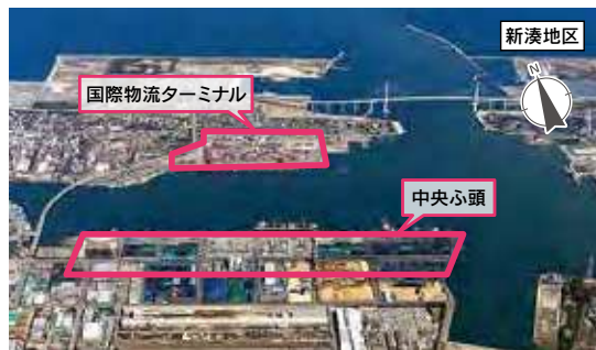
(写真：国土交通省北陸地方整備局提供)
