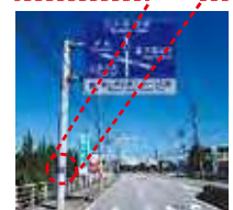
既設道路標識柱への 海拔等の表示
