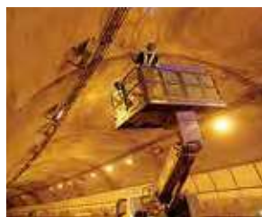
トンネル点検
