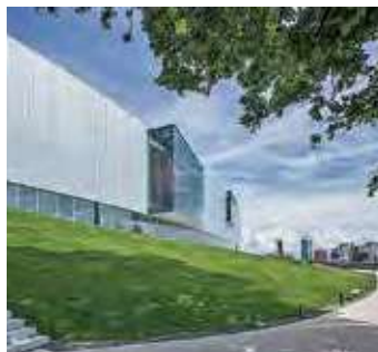
アルミスバンドレルによる外壁 (富山県美術館)
