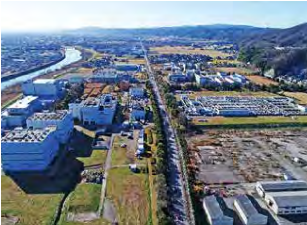
小矢部川流域下水道 二上浄化センター (高岡市二上地内)
