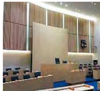
県産材木材壁面ルーバー (富山県議会議事堂)
