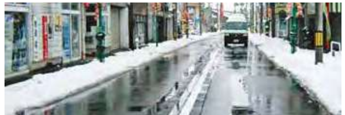
消雪施設の整備
