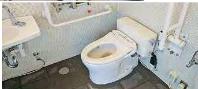
多目的トイレ (海王丸パーク)
