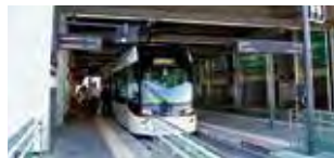
路面電車南北接続
