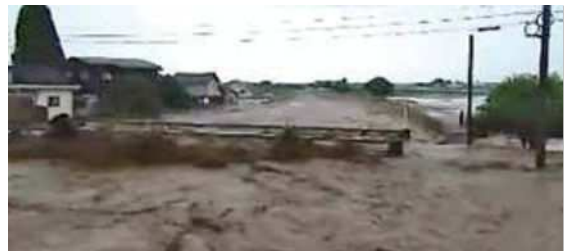
白岩川越水状況（令和5年6月28日）
