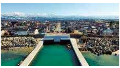
市街地の浸水被害を防ぐため、放水路の整備を進めています！
