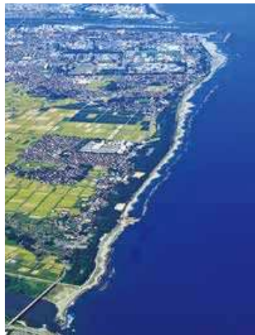
海岸侵食対策事業を進めている富山海岸（富山市）
