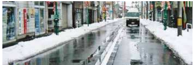
消雪施設の整備
