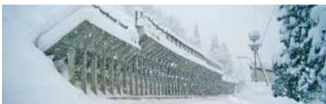
雪崩対策施設
