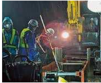
生活インフラを支える夜間工事
