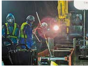
生活インフラを支える夜間工事
